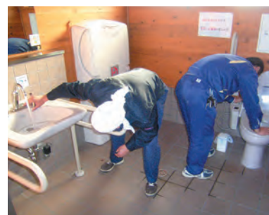
公衆トイレの衛生機器点検
