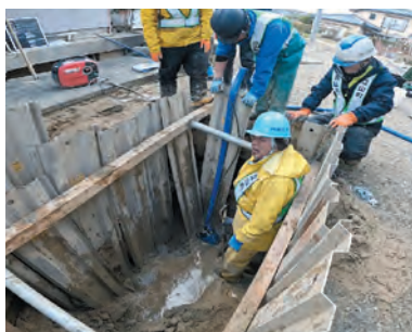
能登災害復旧工事業業
