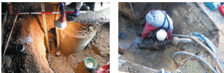
小矢部市内の応急復旧作業
