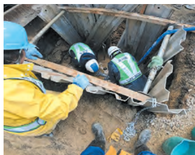
能登災害復旧工事業
