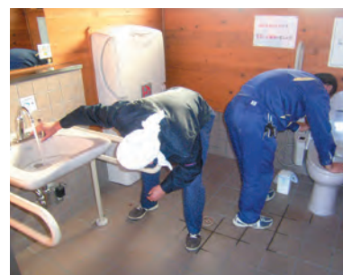
公衆トイレの衛生機器点検
