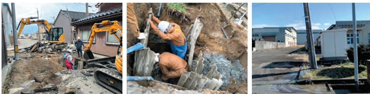
港町での配水管漏水修繕
