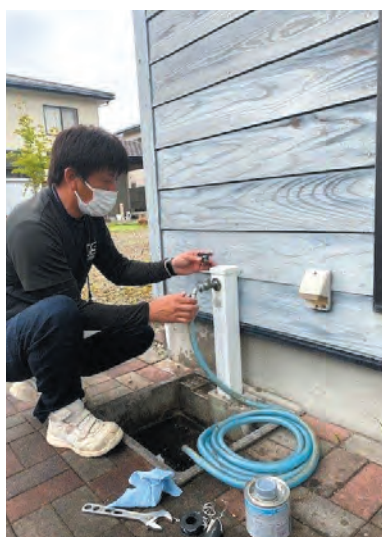
水道蛇口無料点検
