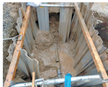
能登災害復旧工事業
