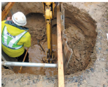
能登災害復旧工事業
