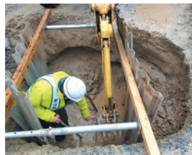
能登災害復旧工事業
